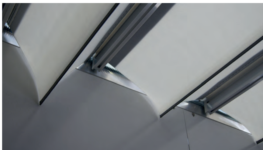
Materiale fonoassorbente per lo smorzamento a fine corsa, pattini di scorrimento autolubrificanti e rulli di metallo rivestito in polimero.
