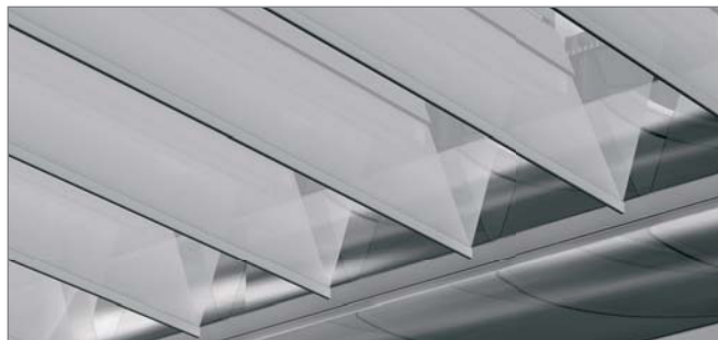
průsvitný materiál s dvojitým švem
