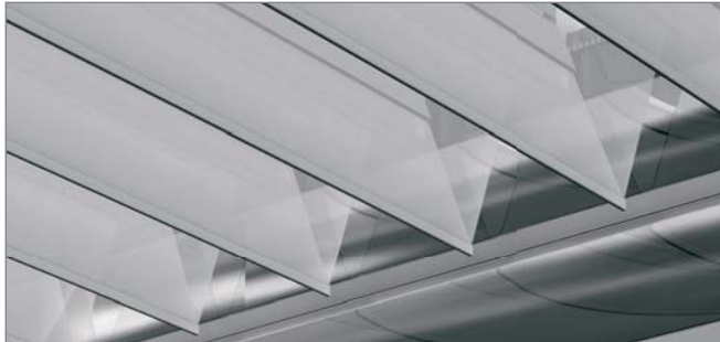
Balgmaterial aus lichtdurchlässigem Gewebe und mit Doppelschussfaden
