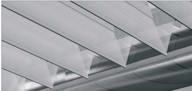
Cubierta del fuelle en tejido translúcido y de doble trama
