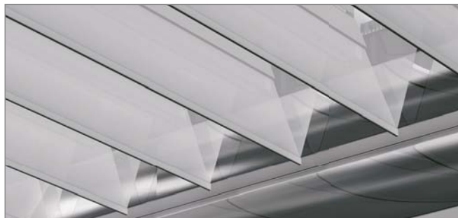
Mantice del soffietto in tessuto traslucido e a doppia trama
